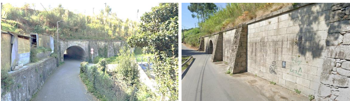
Figura 17 – Três túneis sob a linha ferroviária (VL37)
