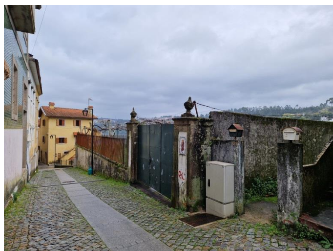
Muro frontal do jardim / miradouro do edifício voltado para a Rua de Santo António de Arnelas.
