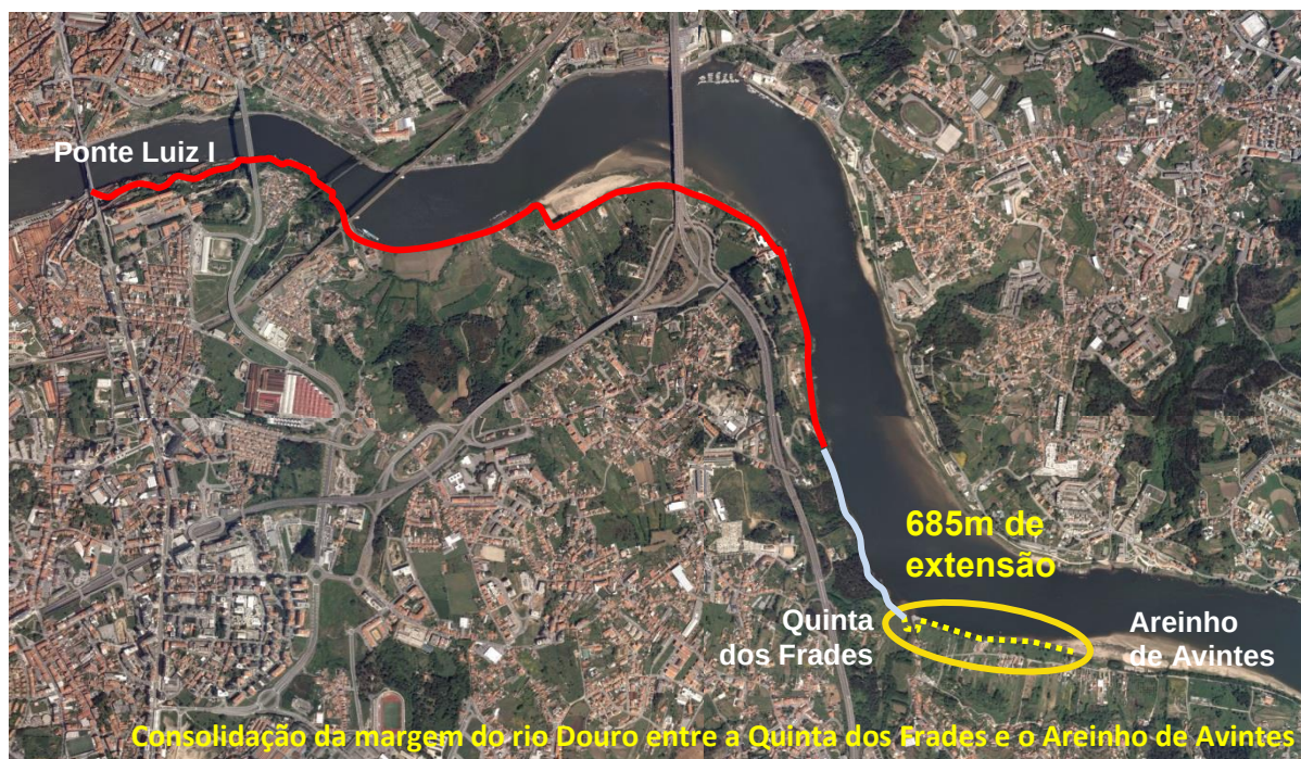
Ortofotomapa 2012 com indicação das intervenções executadas
