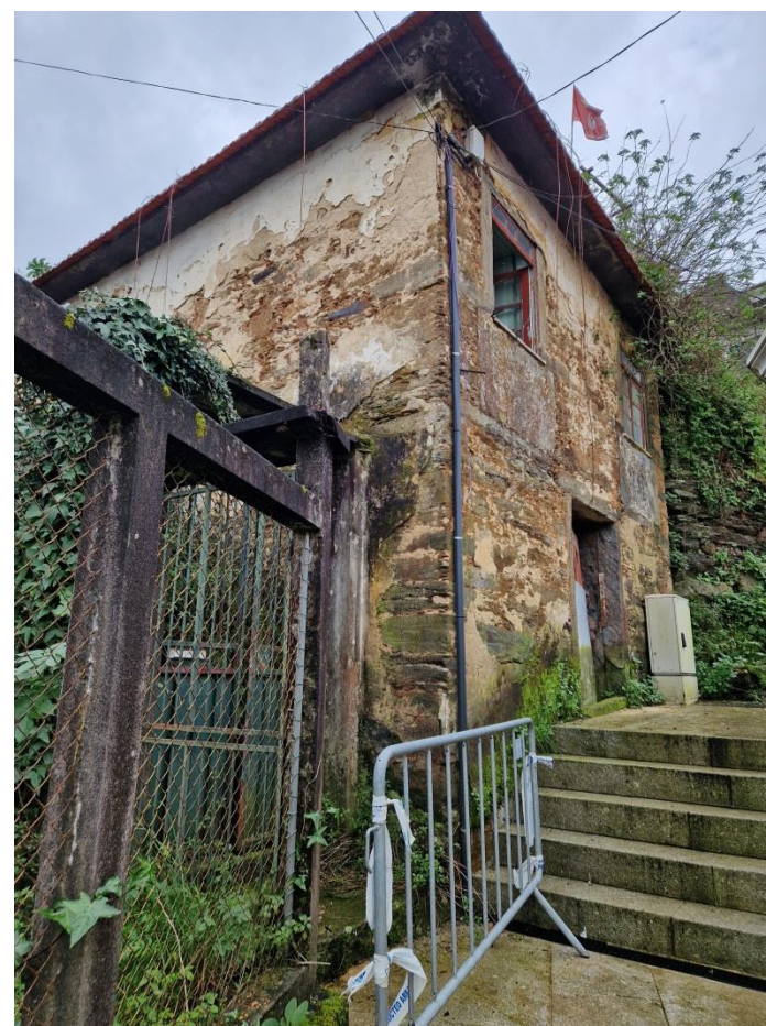
Fachada principal do edifício voltada para as Escadas de São Mateus A construção não tem acesso automóvel
