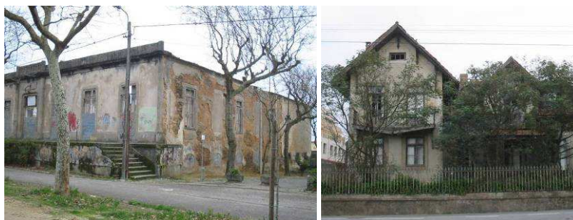
Edifício da Assembleia da Granja – SF26; Casa do escritor Eça de Queiroz – AR37
