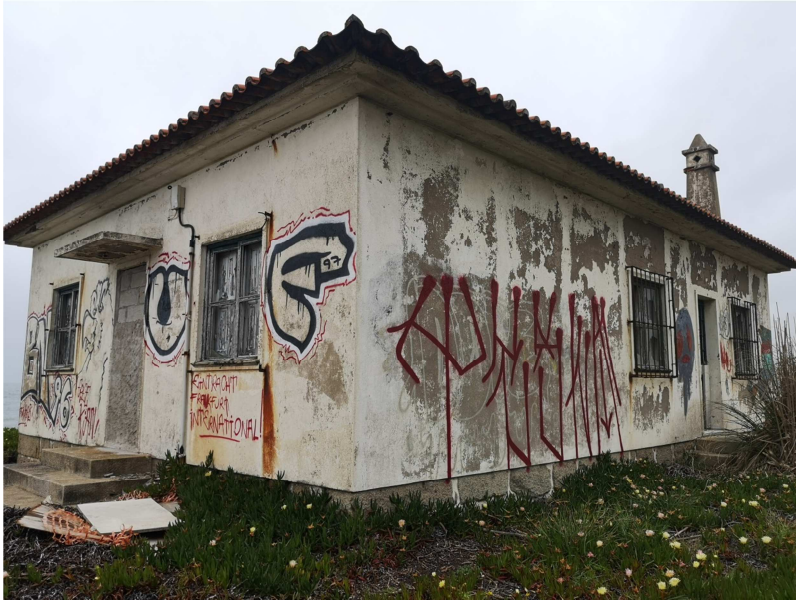
Fachadas sul e nascente
