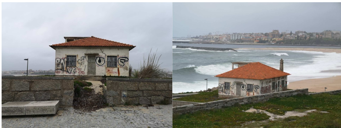
Fotografias Gaiurb EM – vistas sul e sudoeste do Antigo Posto Fiscal de Lavadores
